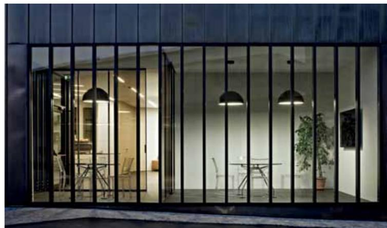
Sopra, esterno e interno dell'ingresso e reception dello stabilimento Cimbalì. Accanto, il passo del serramento coincide con quello del rivestimento in lamiera di rame (foto ©Germano Borrelli).
